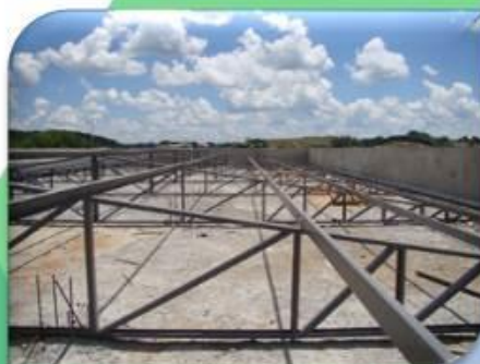
Instalação de estrutura metálica de cobertura
