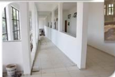
Corredor e rampa de acesso
