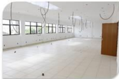
Sala em obras.
