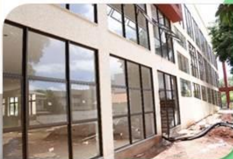
Vista lateral norte da obra.
