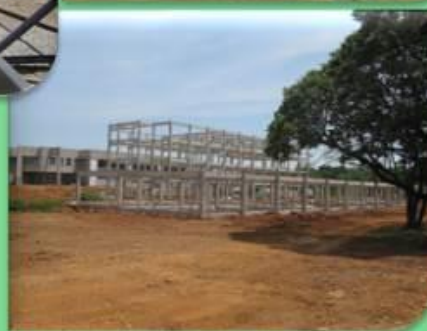
Instalação de estrutura pré-moldada BLOCO 4
