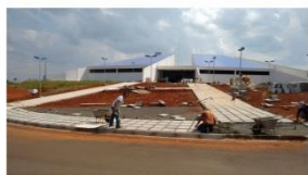
Finalização da fachada e parte externa.
